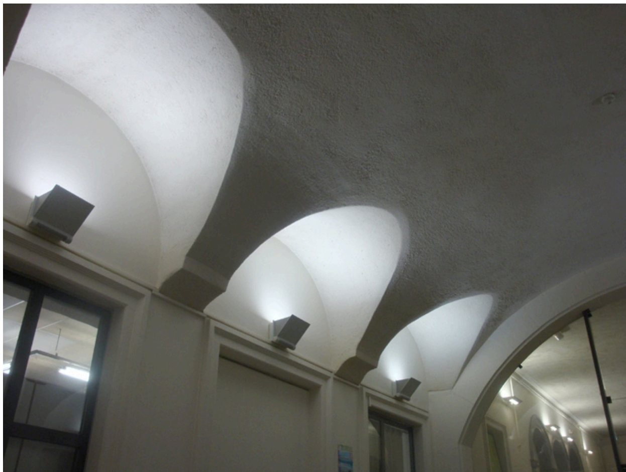
Détail voûtes ludothèque, rez-de-chaussée
