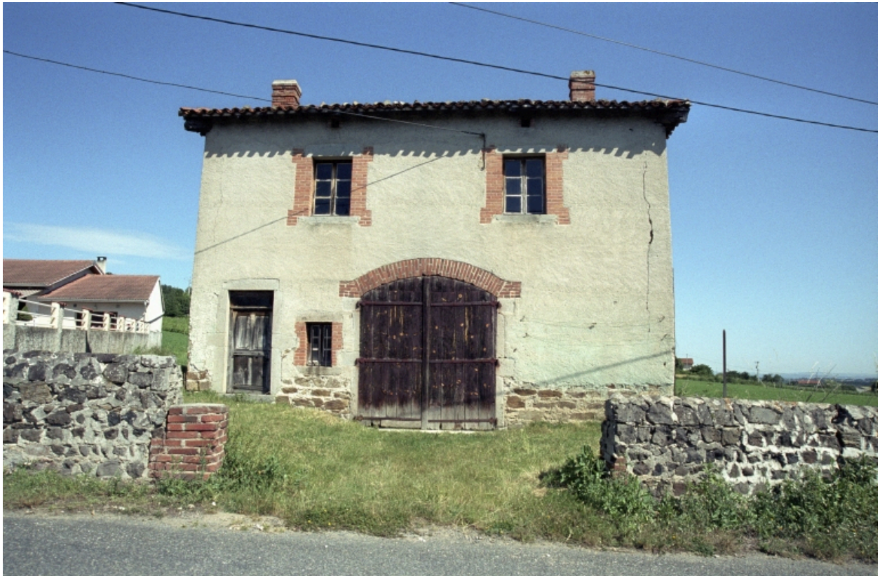
Marcilly-le-Châtel, le Ravat, parcelle 1987 A1 199. Vue d'ensemble de face.
