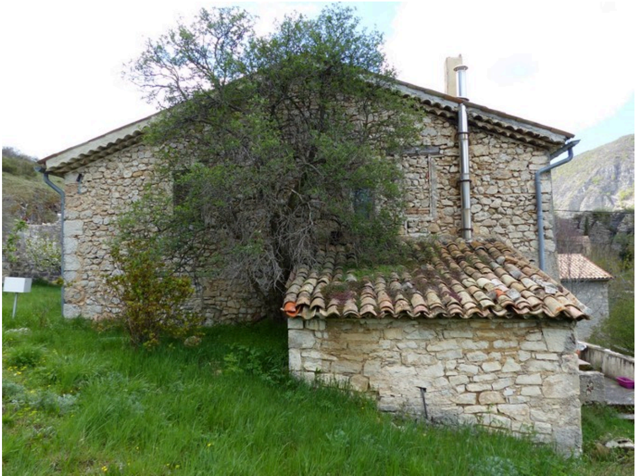
Bâtiment du logis. Pignon nord.
