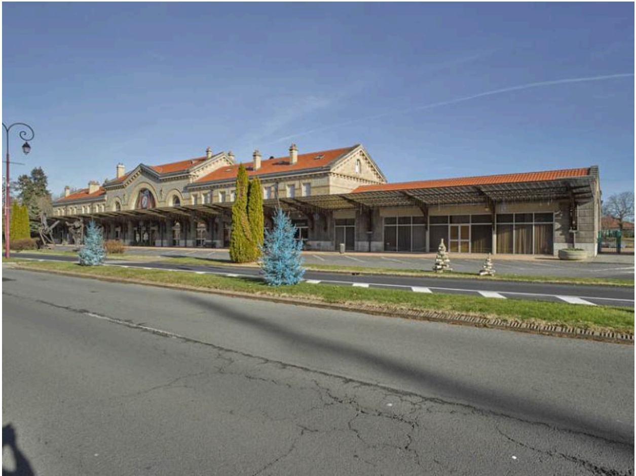
La gare de Châtel-Guyon, depuis le sud-ouest, du côté de l'ancienne cour des voyageurs.
