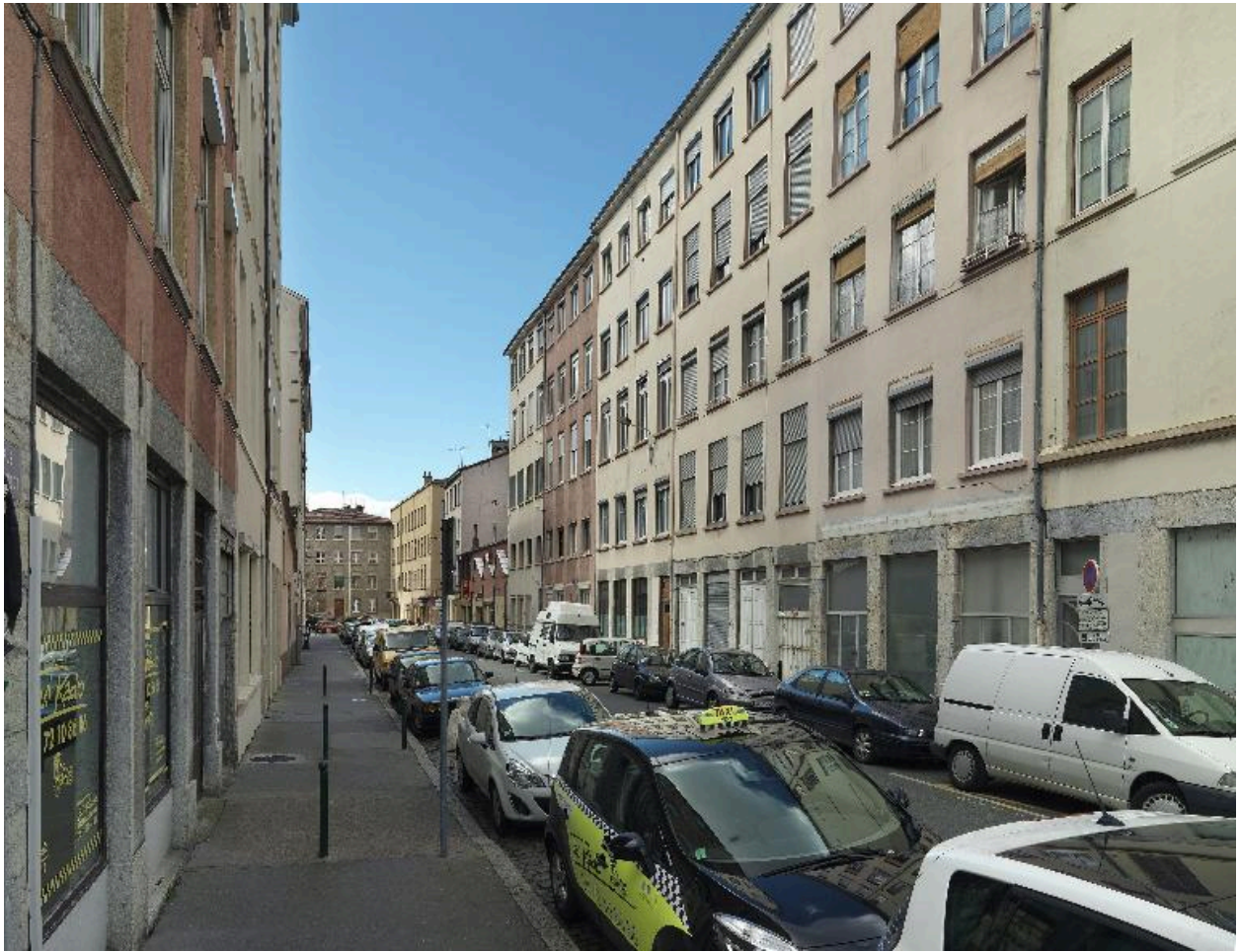
Profil rue Gigodot en prolongement de l'impasse et à l'est de la rue Belfort
