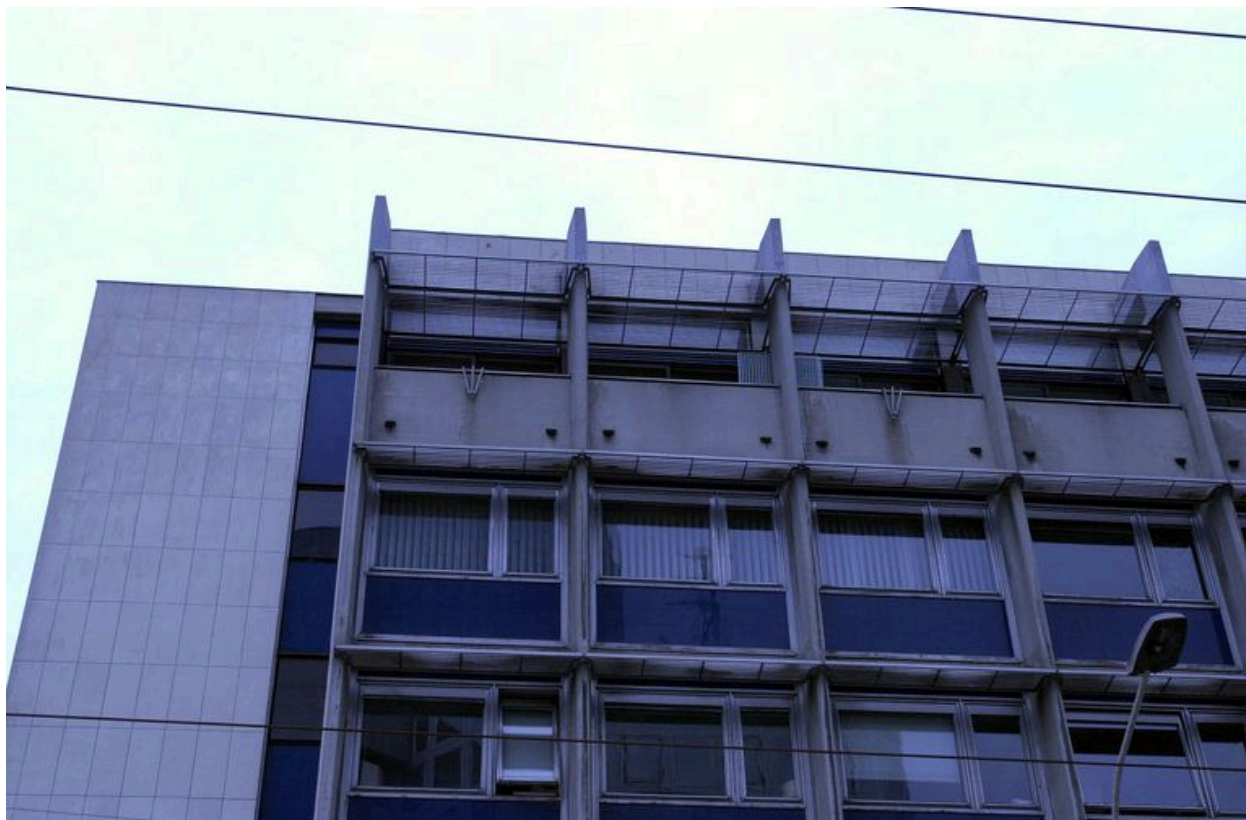
Vue extérieure : élévation sud, détail des étages supérieurs
