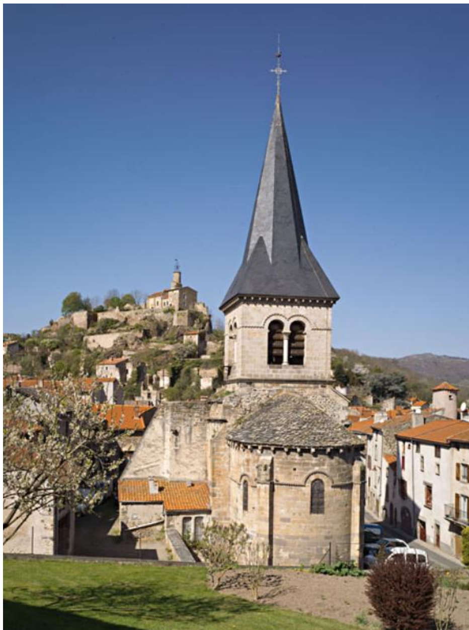
Vue générale côté est.
