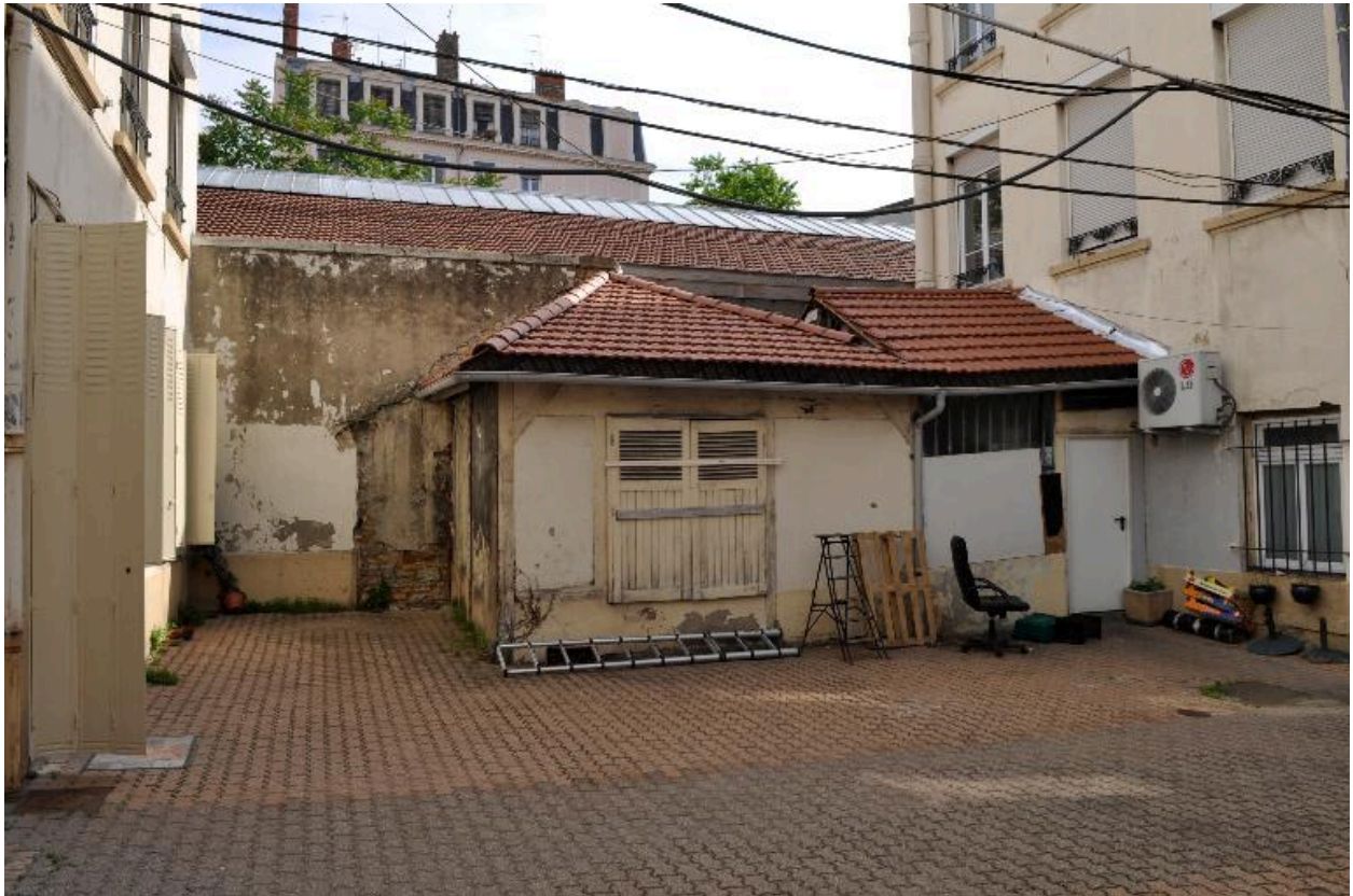
Remise située dans la cour, côté nord
