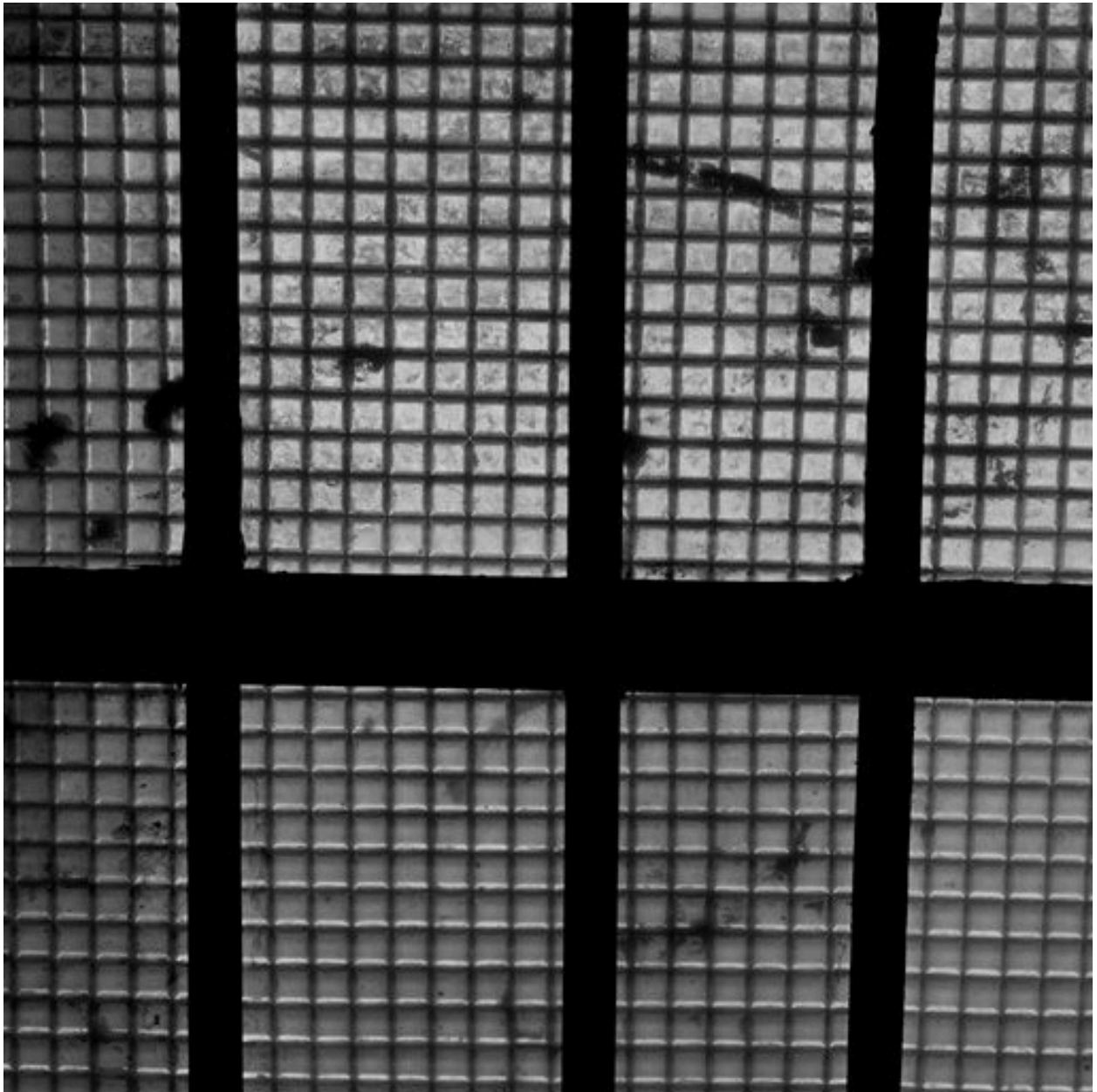
4e étage : sol en dalles de verre, vu du dessous
