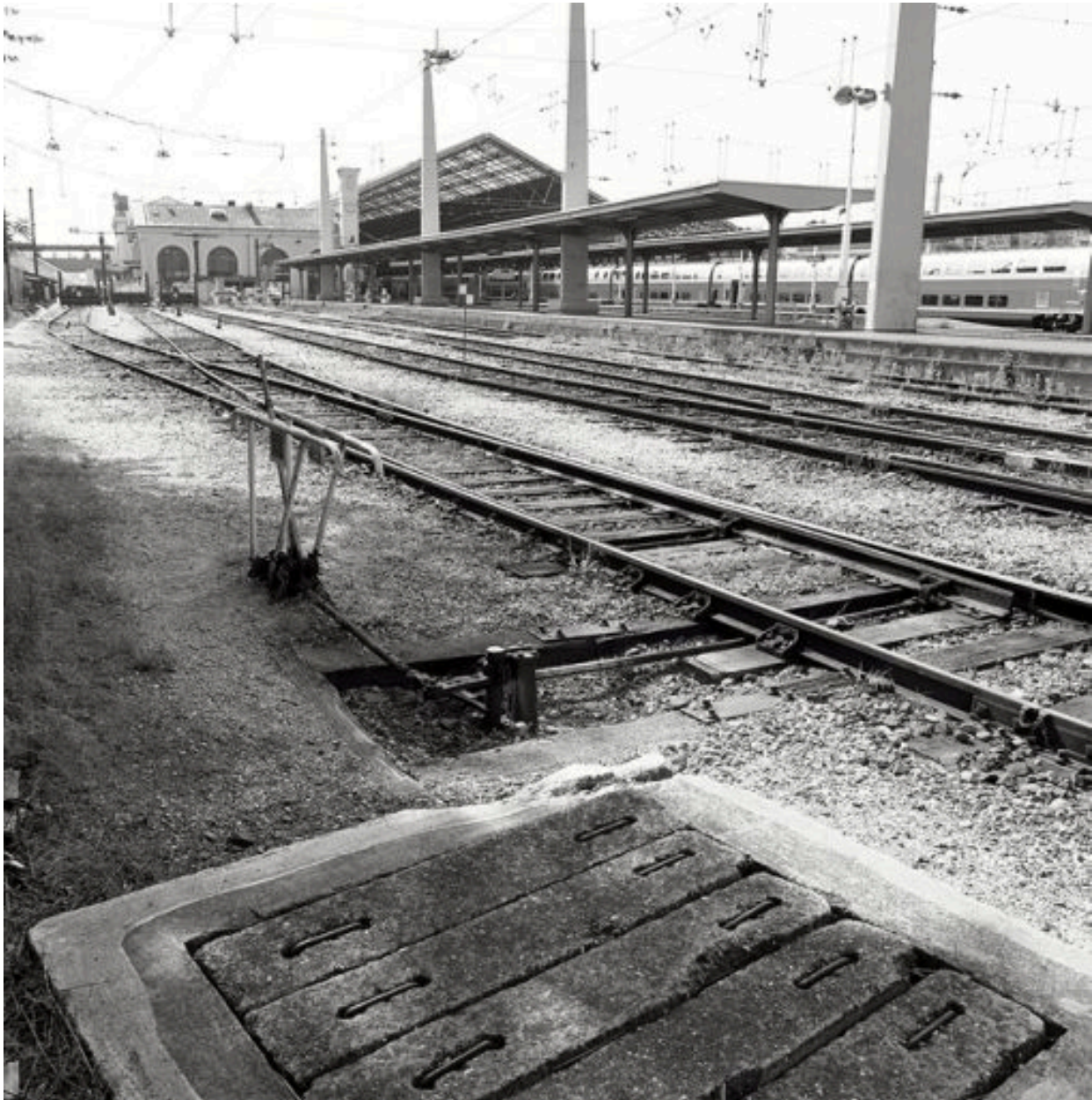
L'aiguille manuelle 103 et les quais sous abris parapluie vers Saint-Etienne
