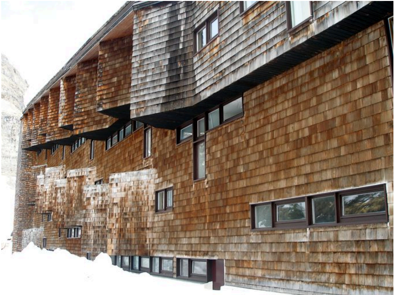
Vue de l'élévation nord
