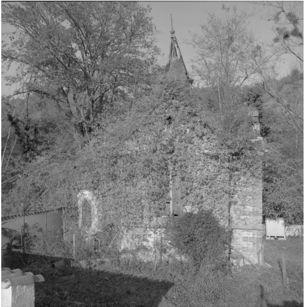
Vue d'ensemble de l'élévation latérale gauche.
