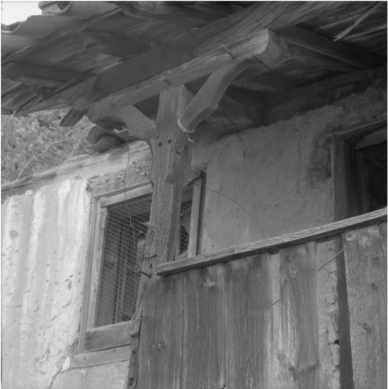
Détail d'un poteau de l'aître du logis.
