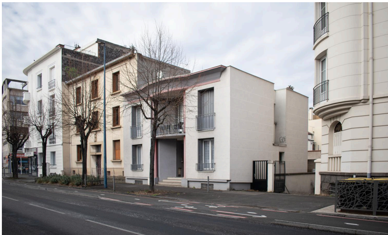
Façades sur le boulevard Jean-Jaurès. Étagement des volumes.
