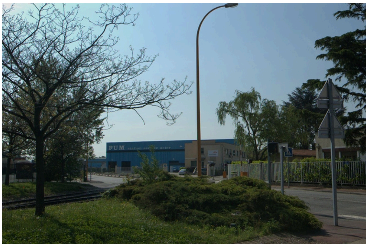
Vue des espaces de circulation et entrepôt PUM
