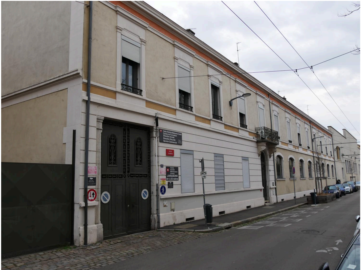
Façade du dépôt TCL et ateliers d'entretien
