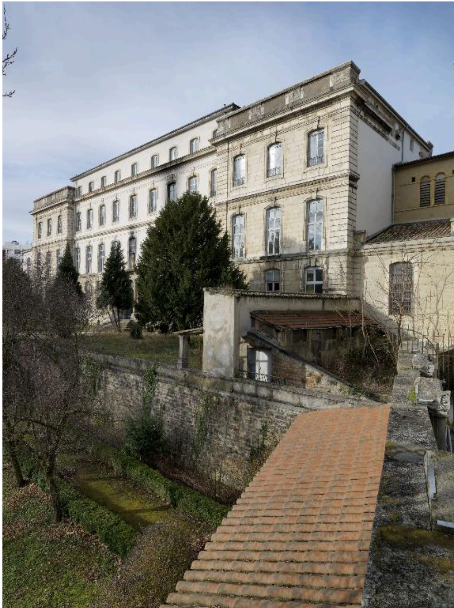
Prieuré, élévation est : vue générale depuis la terrasse du calvaire de Saint-Irénée
