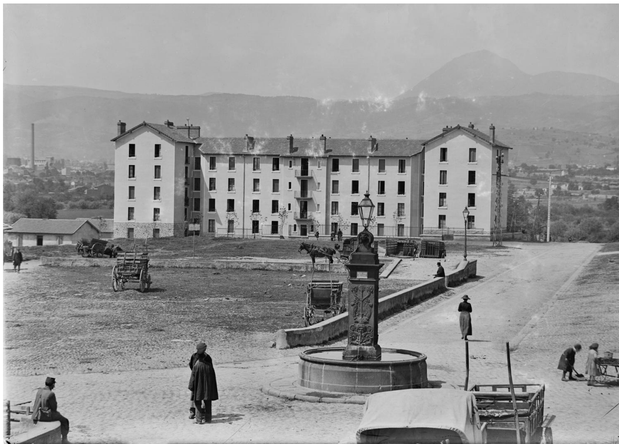
Immeuble collectif de la cité ouvrière de la Rodade (1916).
