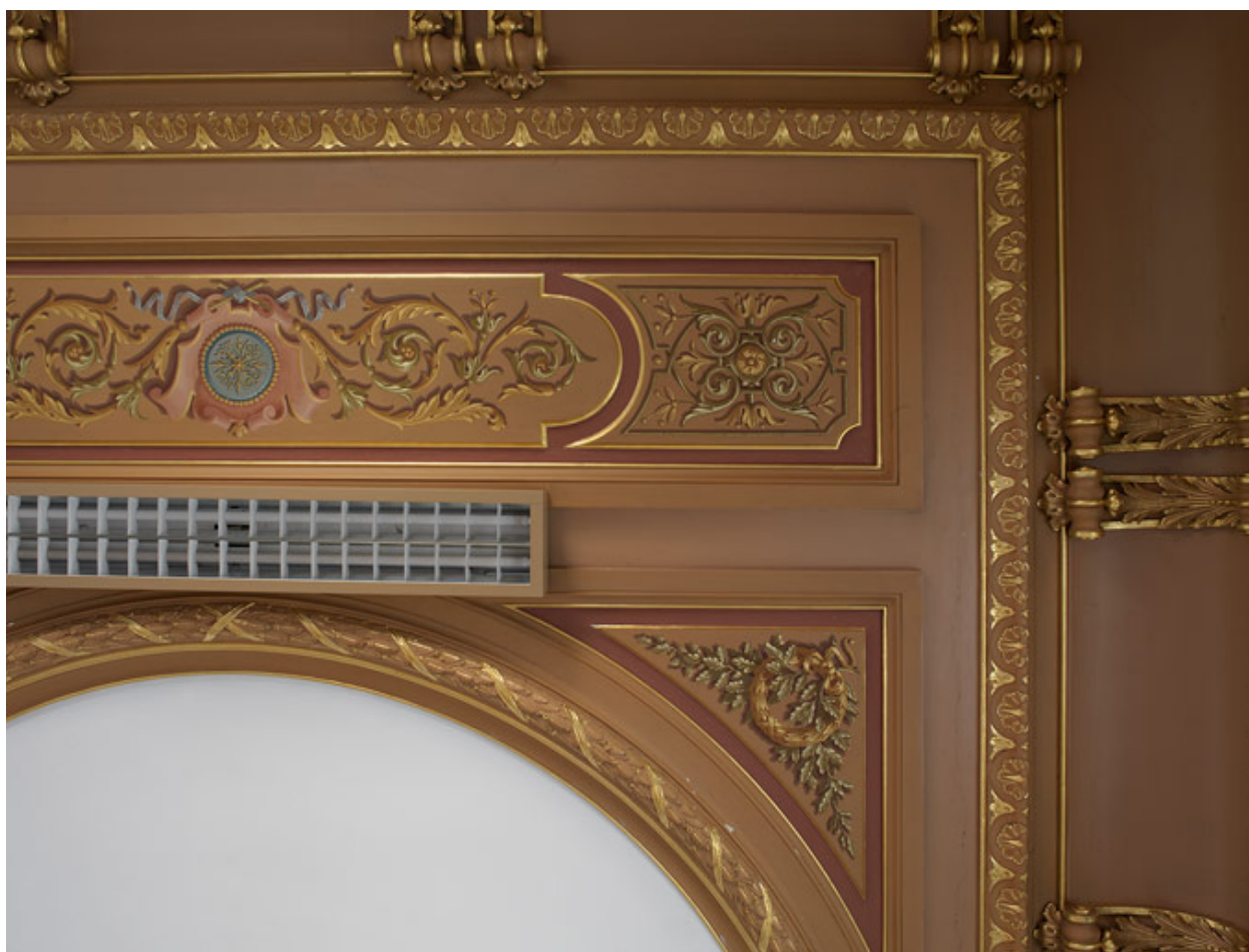
Salon : détail du plafond orné.
