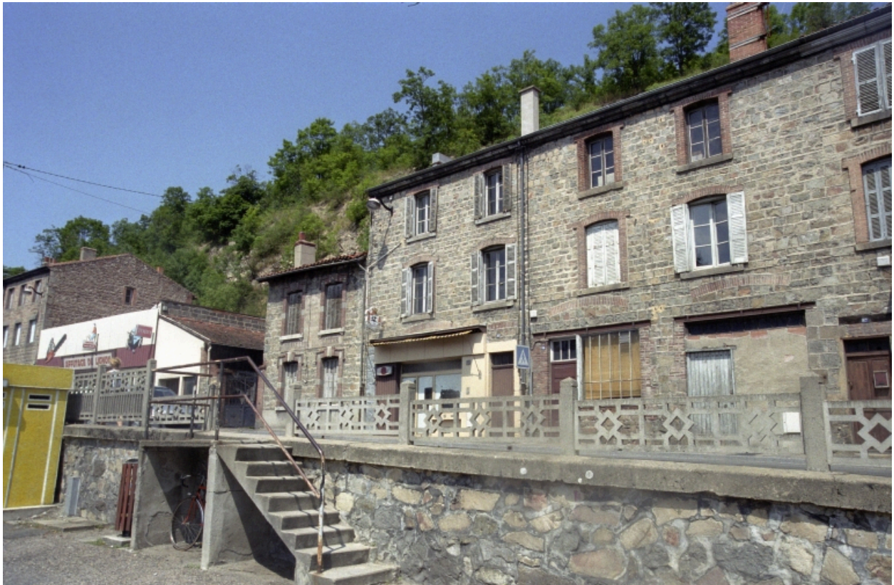
Boën, îlot 17, Lyon (rue de) 85 et 83 et 81. Vue générale de la façade sur rue.
