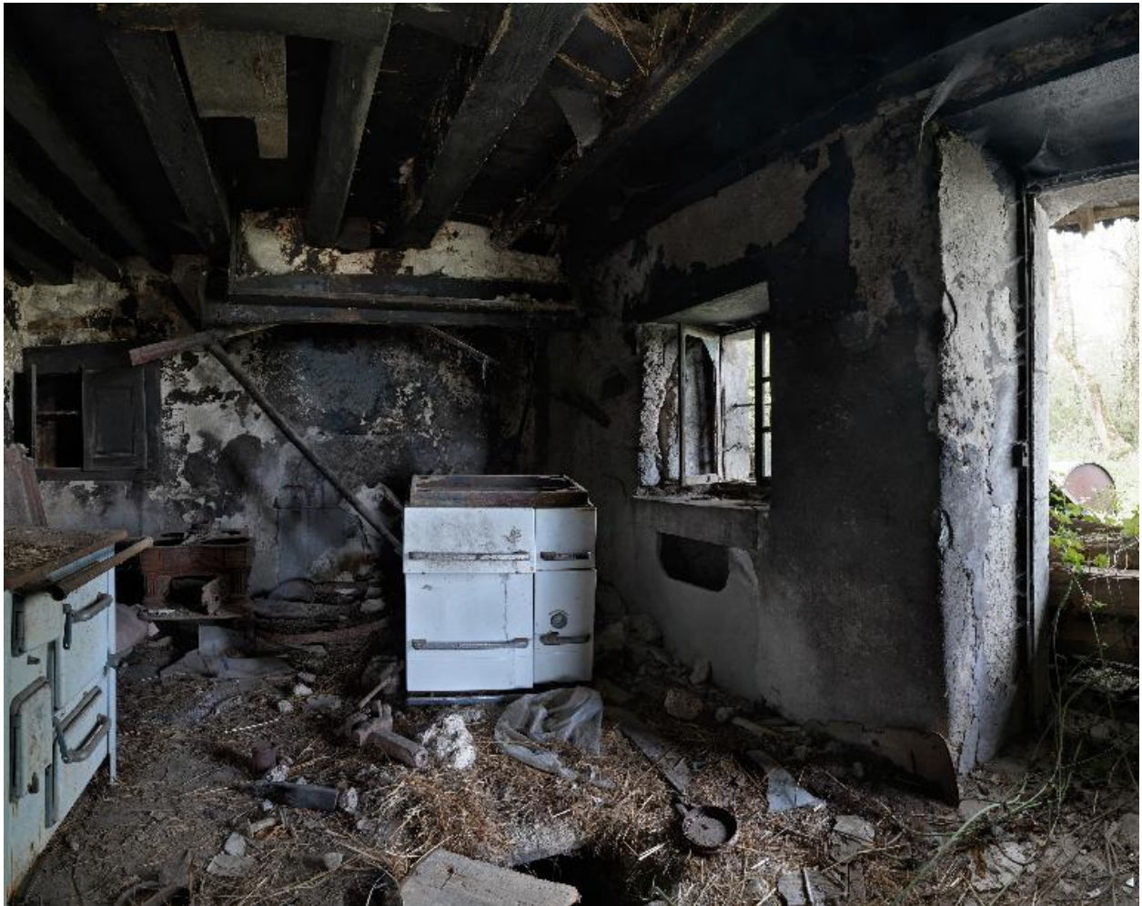
Vue d'ensemble intérieure de la cuisine.
