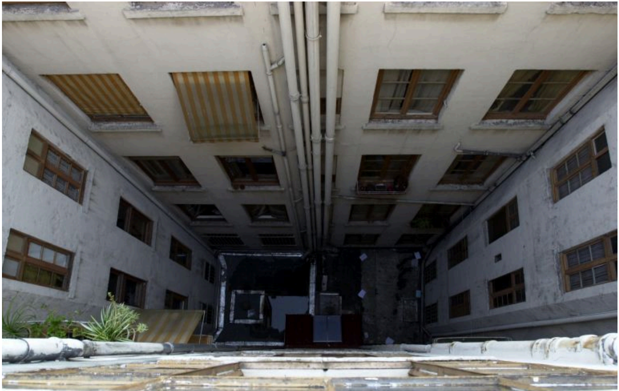
Vue générale de la cour depuis le 1er corps de bâtiment
