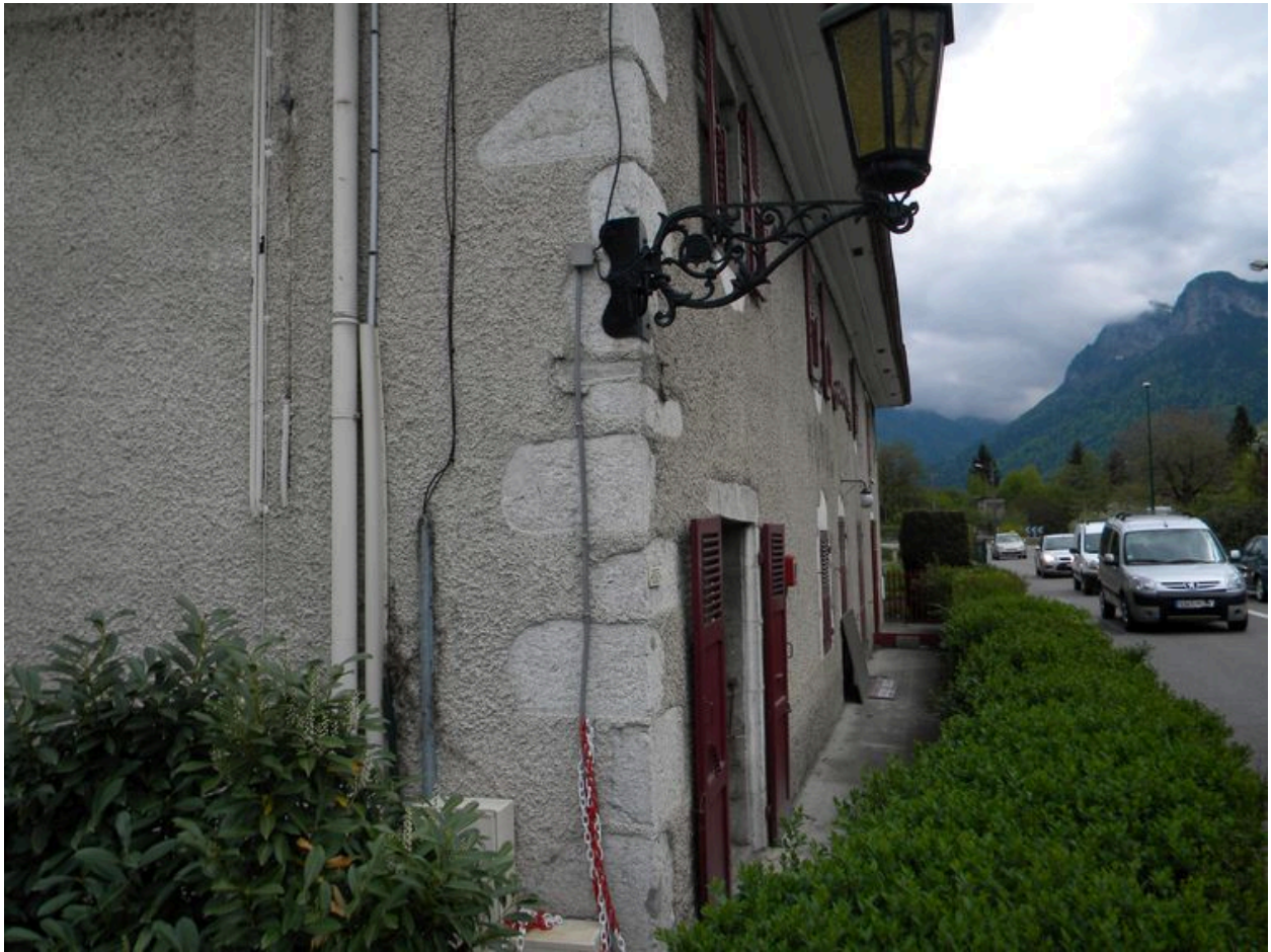
Alignement de façade et chaînage d'angle.
