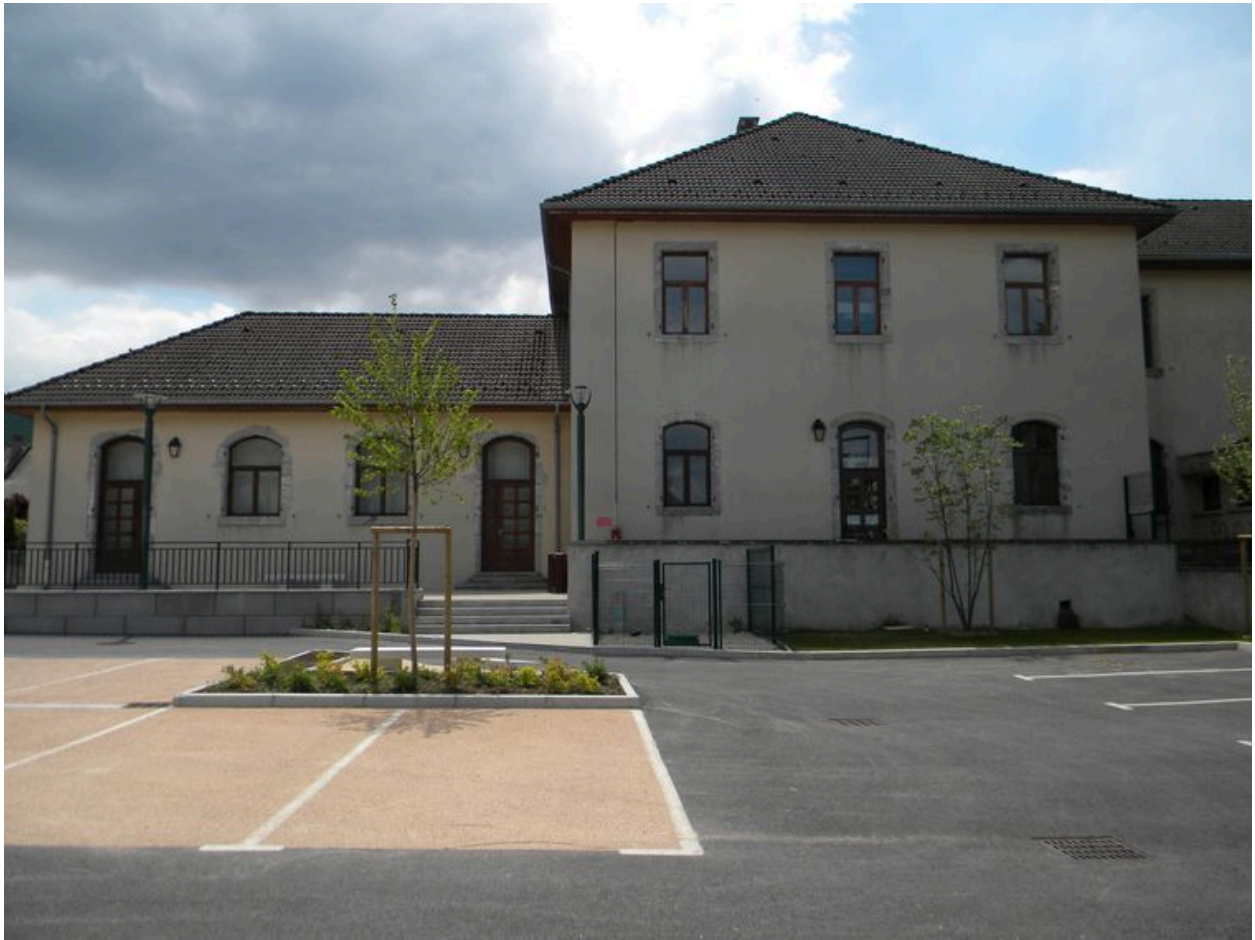
Vue de la façade arrière.
