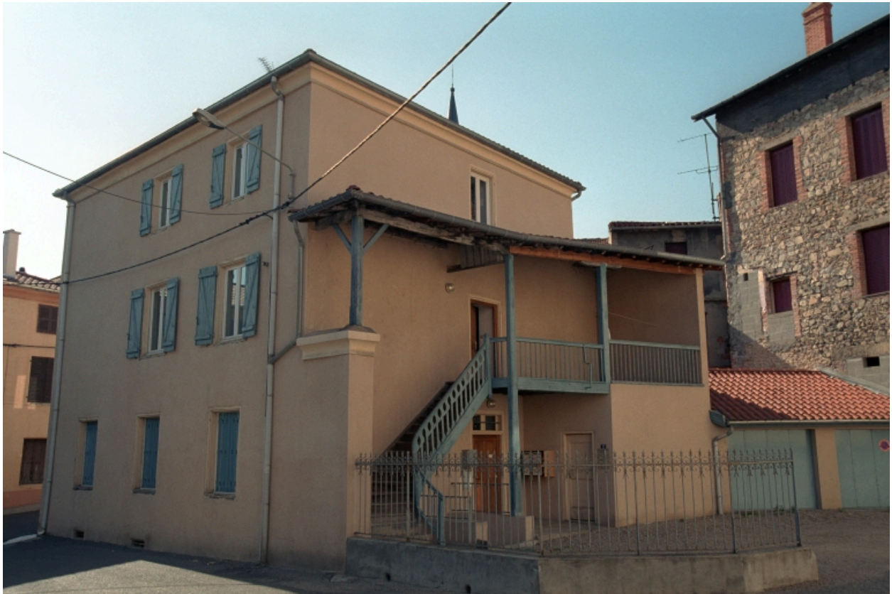
Boën, îlot 18, Emile Mandrillon (place) 8. Vue générale de la façade sur rue.
