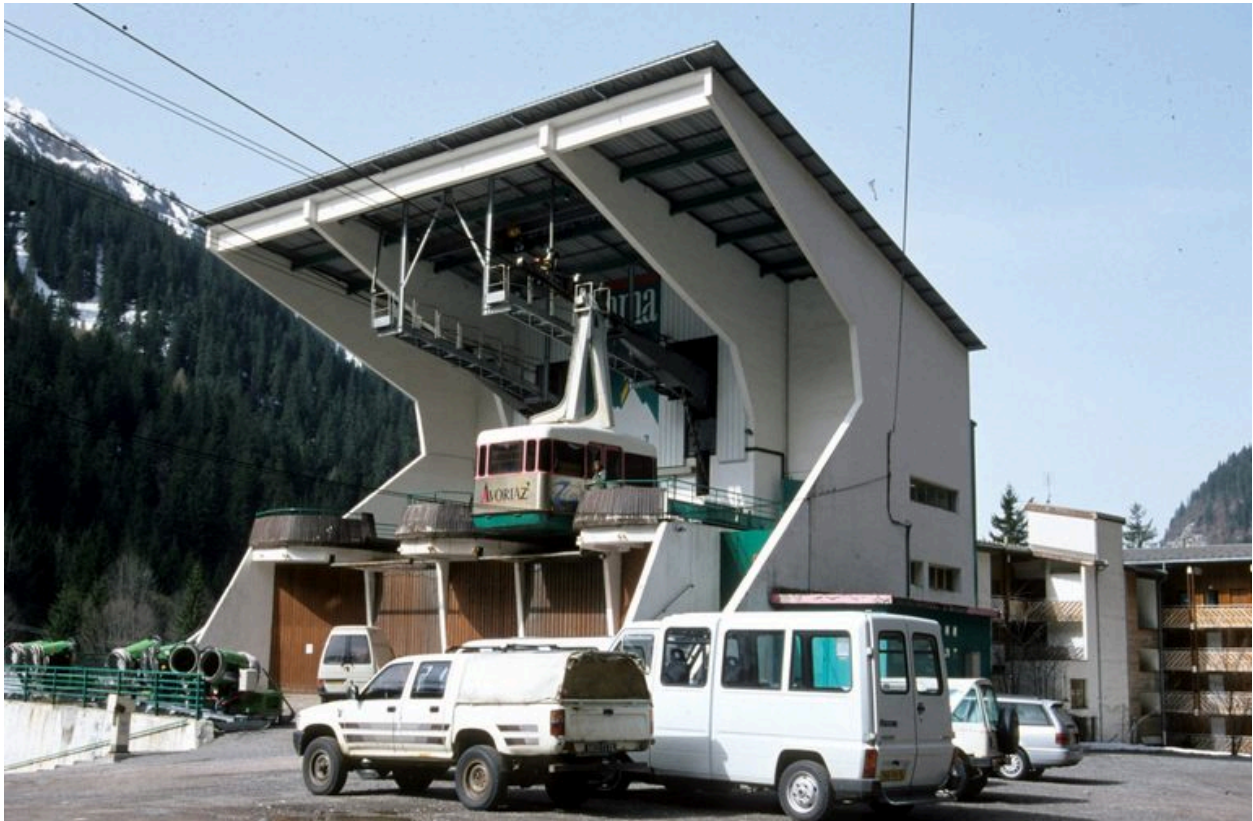
Vue d'ensemble depuis le nord. Photogr. 1999
