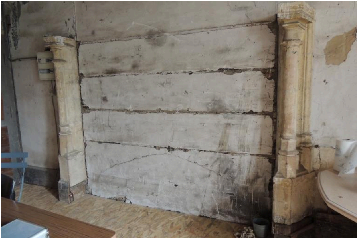
Étage noble, cheminée traversante, côté est.
