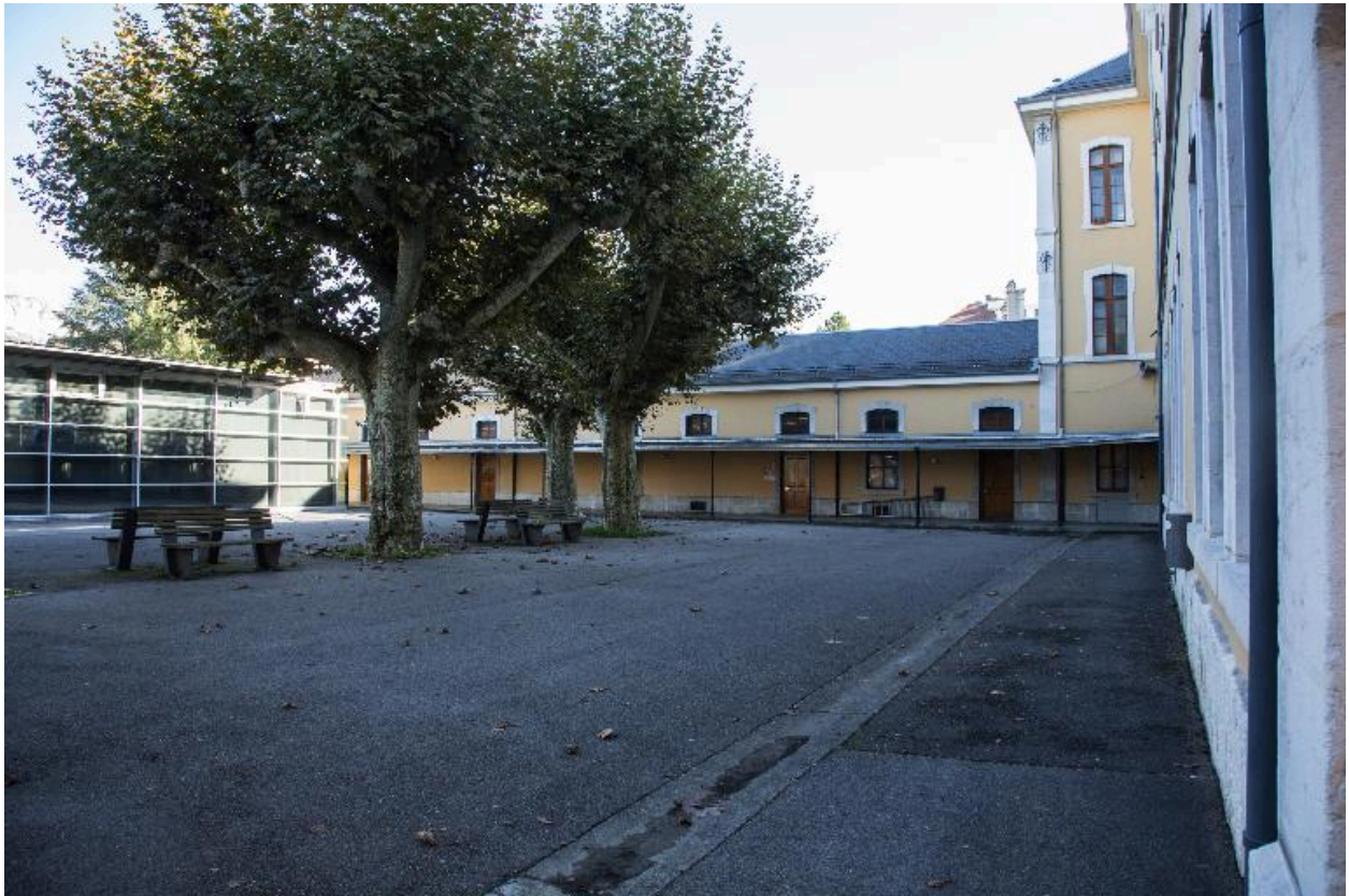
Cour 1 : vue vers le sud-est.
