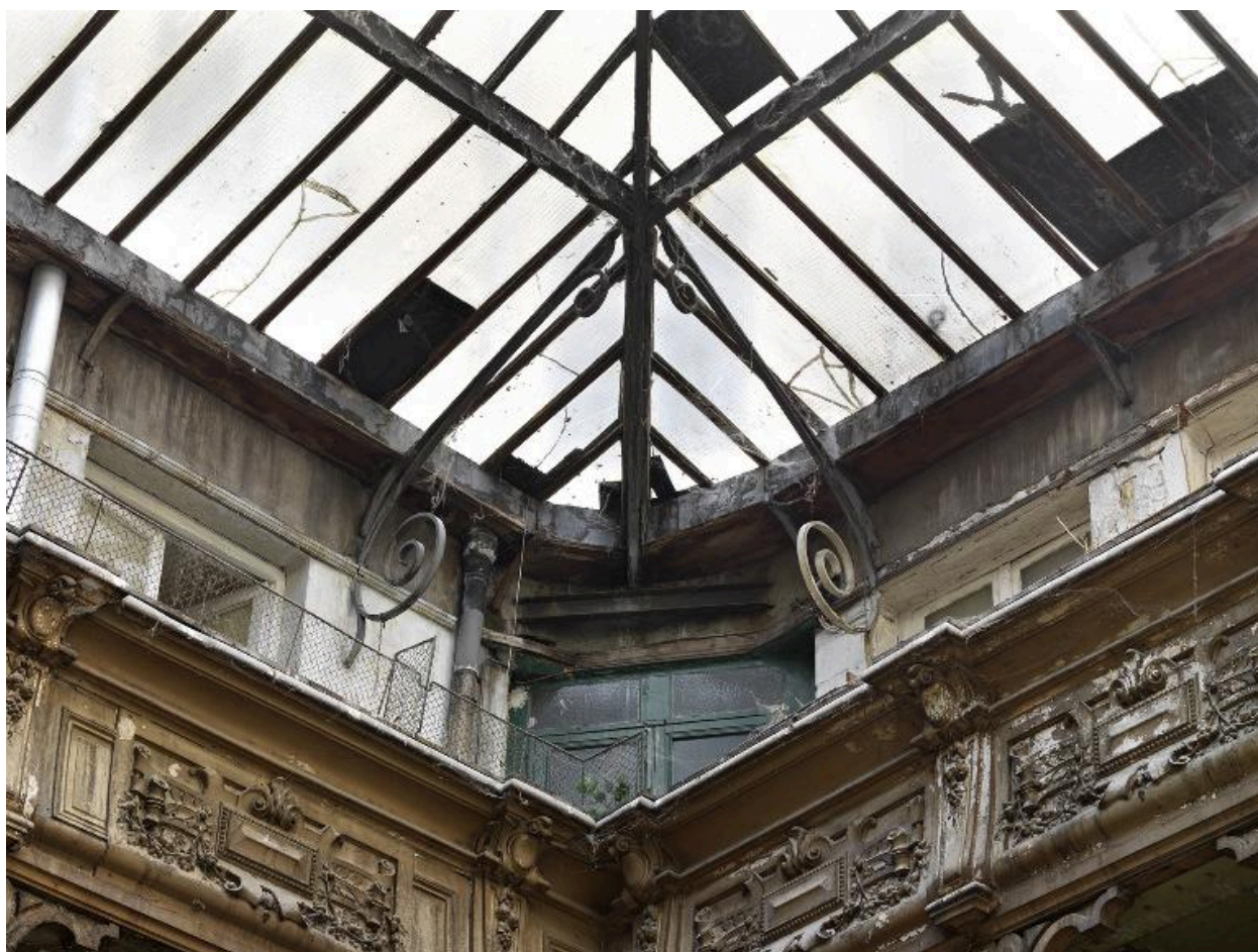
Cour, verrière zénithale, détail de la charpente
