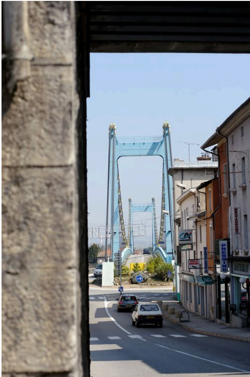
Vue du pont depuis une rue de Serrières
