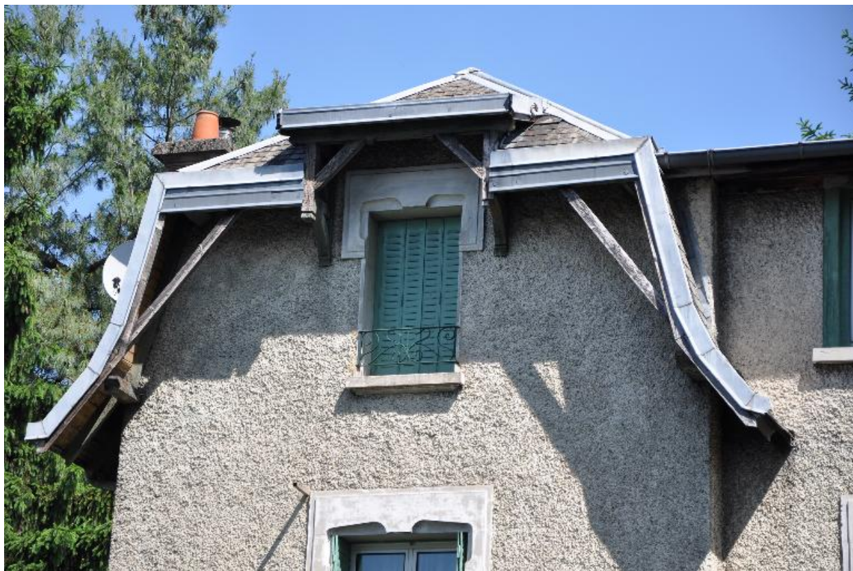
Détail de la lucarne et des aisseliers en bois
