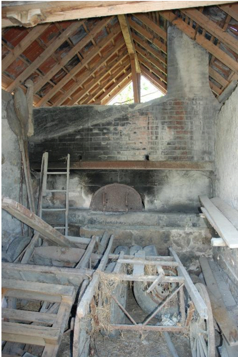
Vue d'ensemble intérieure du four.
