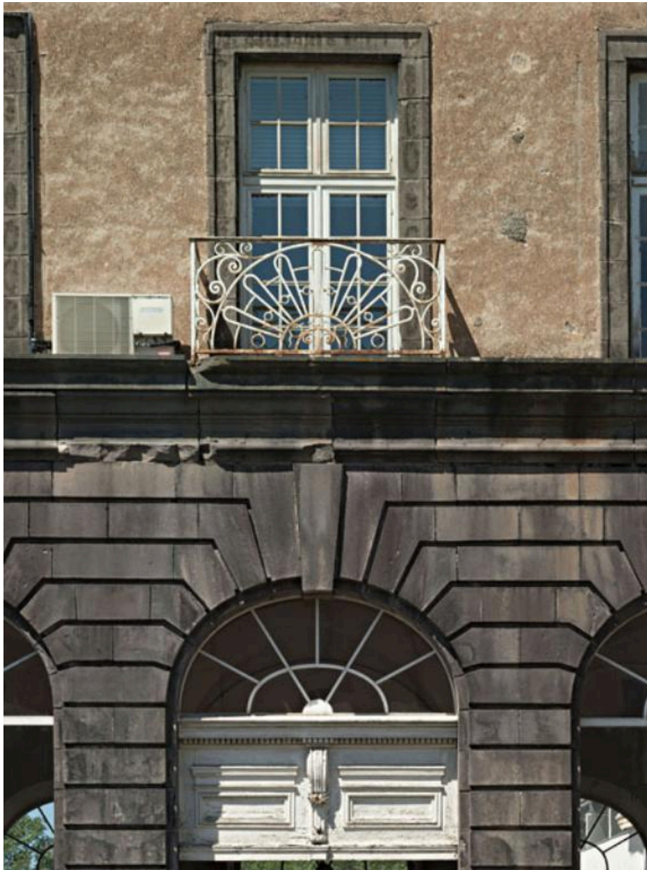
Hôtel-Dieu de Clermont-Ferrand. L'hôtel-Dieu, façade sud du corps de bâtiment nord, détail de la travée axiale.
