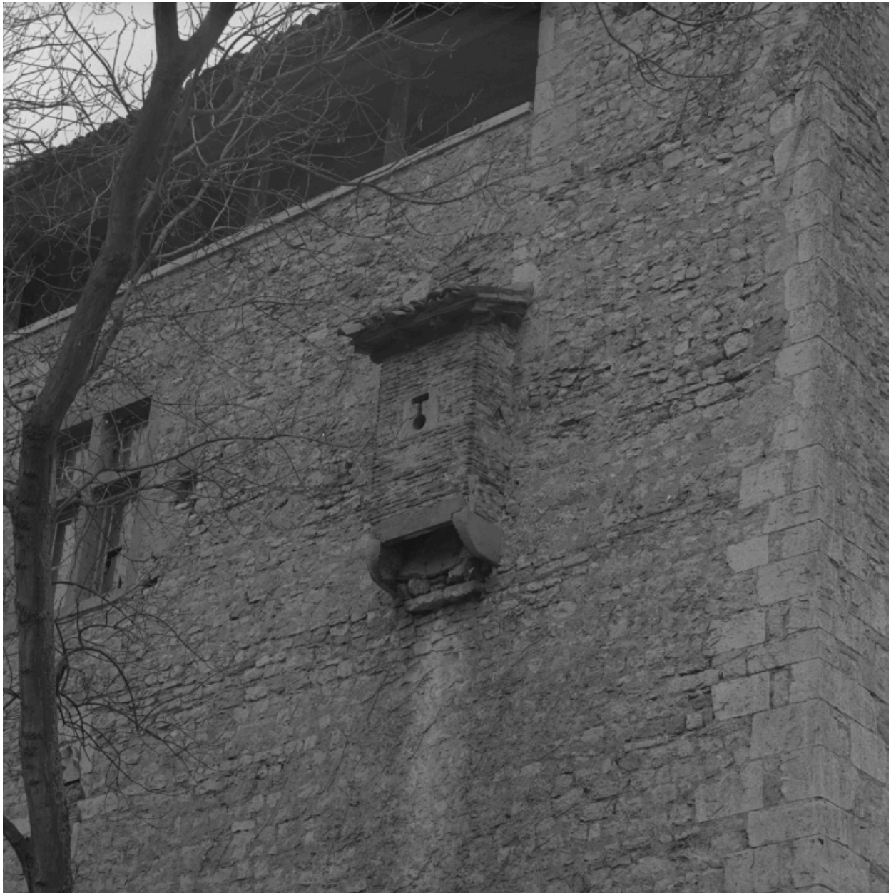
Latrine, au 3e niveau, élévation postérieure.
