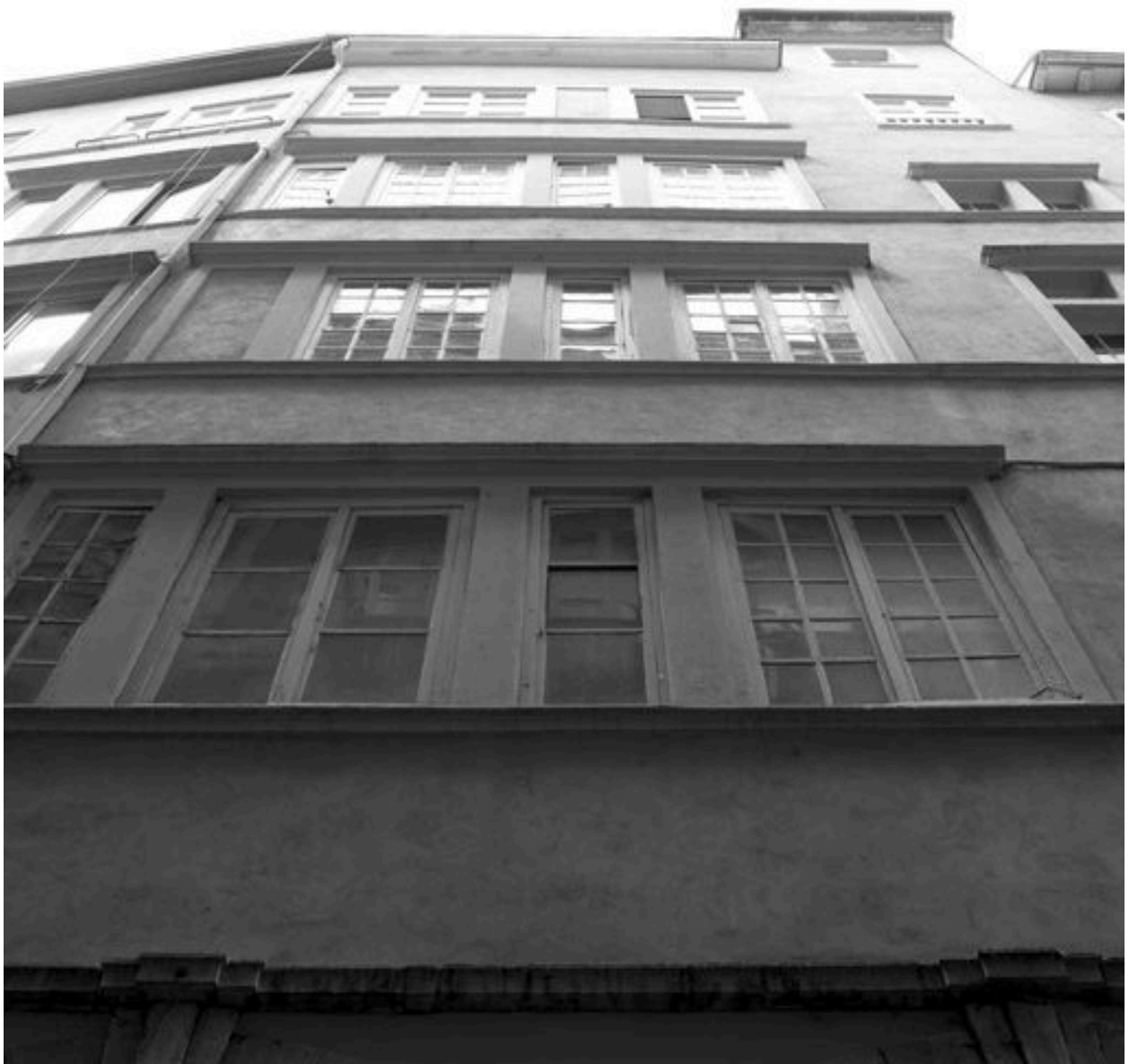
Façade, vue générale par-dessous
