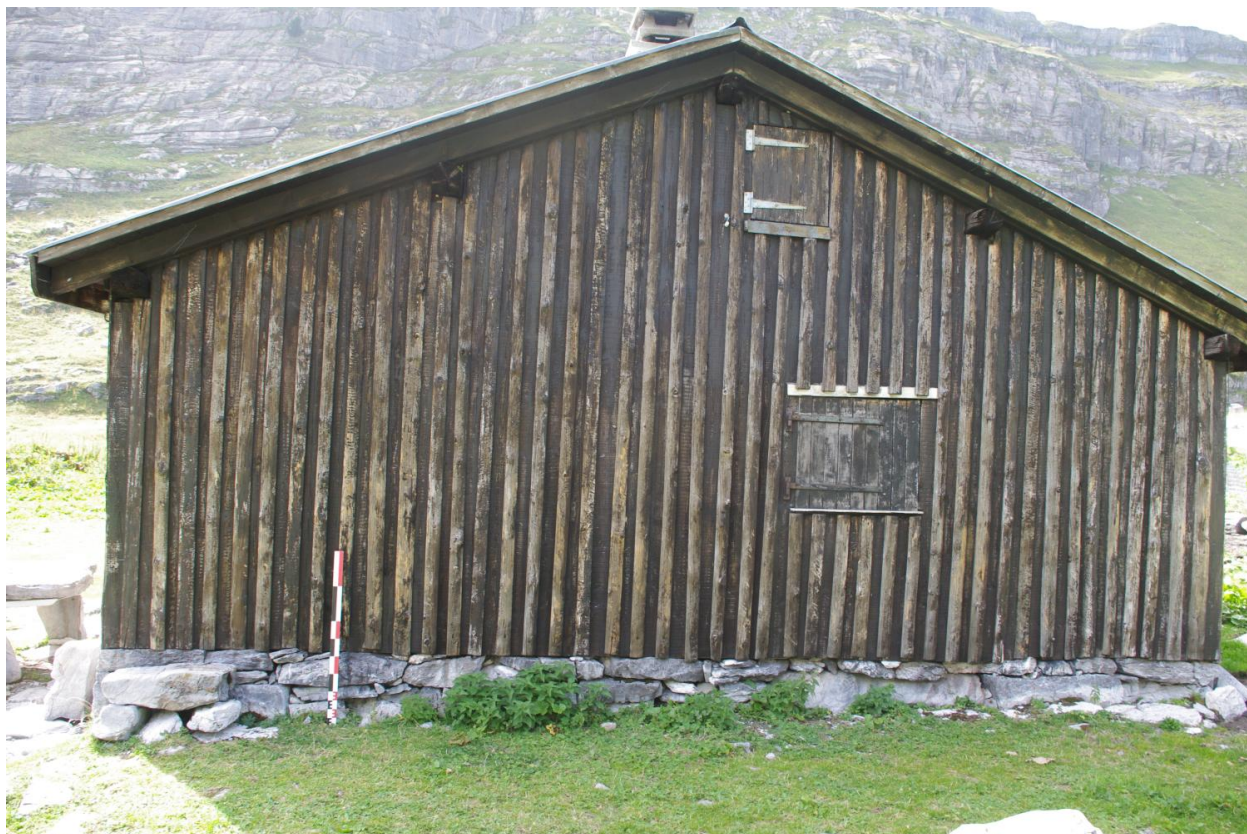
Vue du mur pignon est
