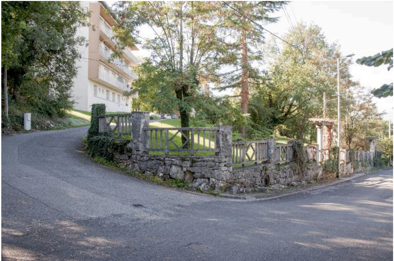
Barrière en ciment et entrée de la résidence Le Solarium
