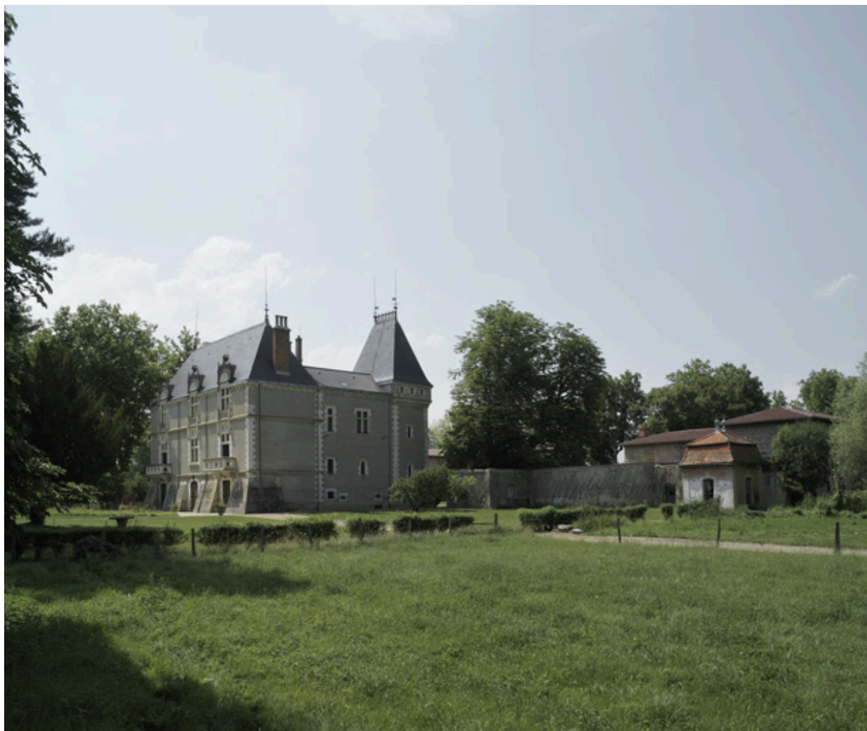
Vue générale de la façade est, de trois-quarts sud-est, depuis le jardin.
