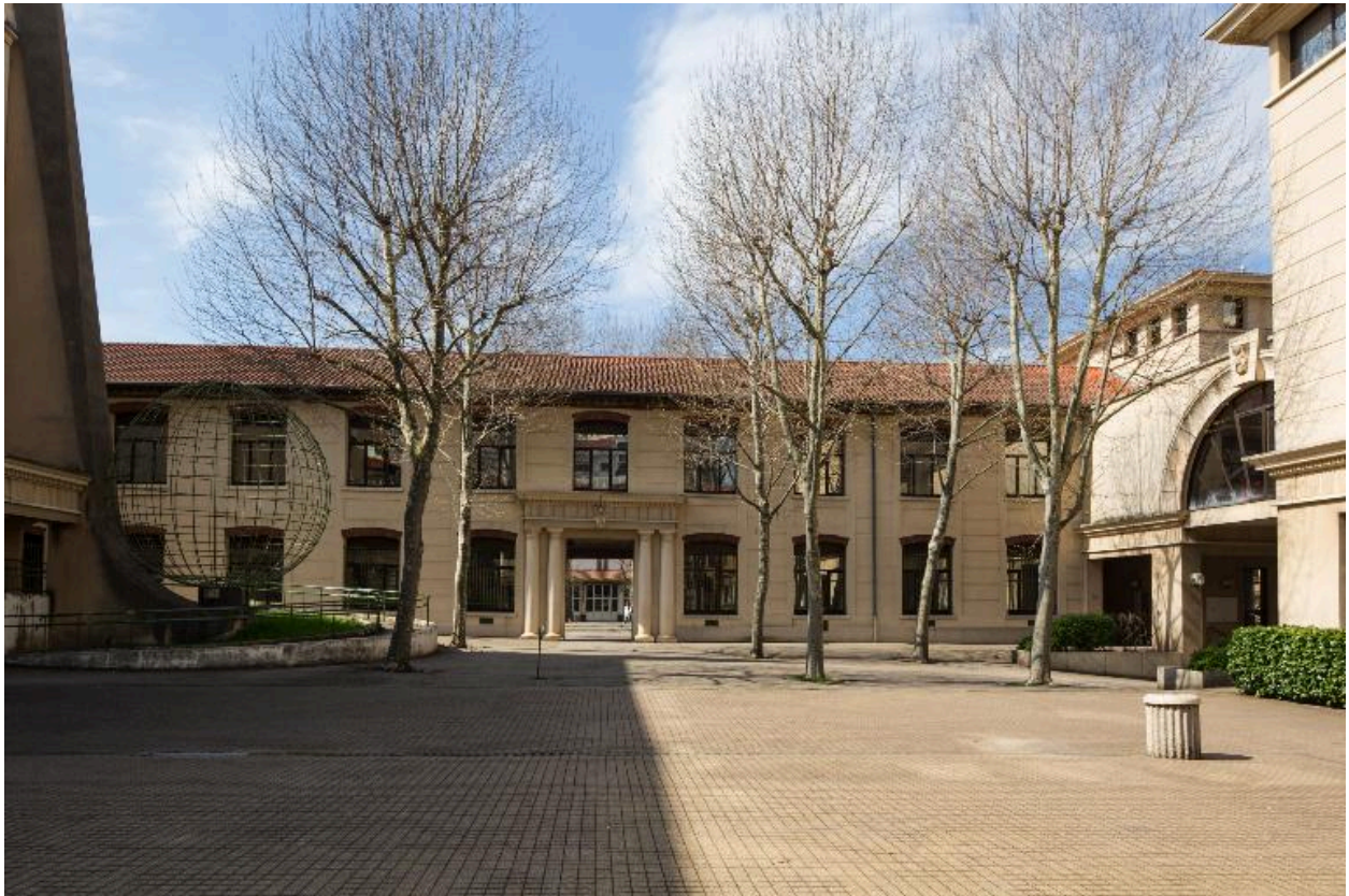
Vue sur bâtiment A depuis la seconde cour
