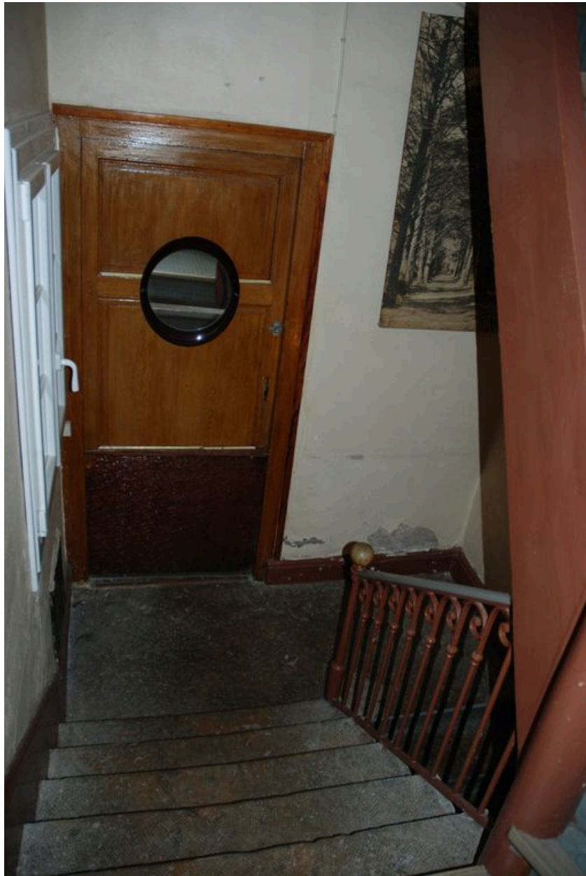
Vue du palier situé entre le rez-de-chaussée et le premier étage.
