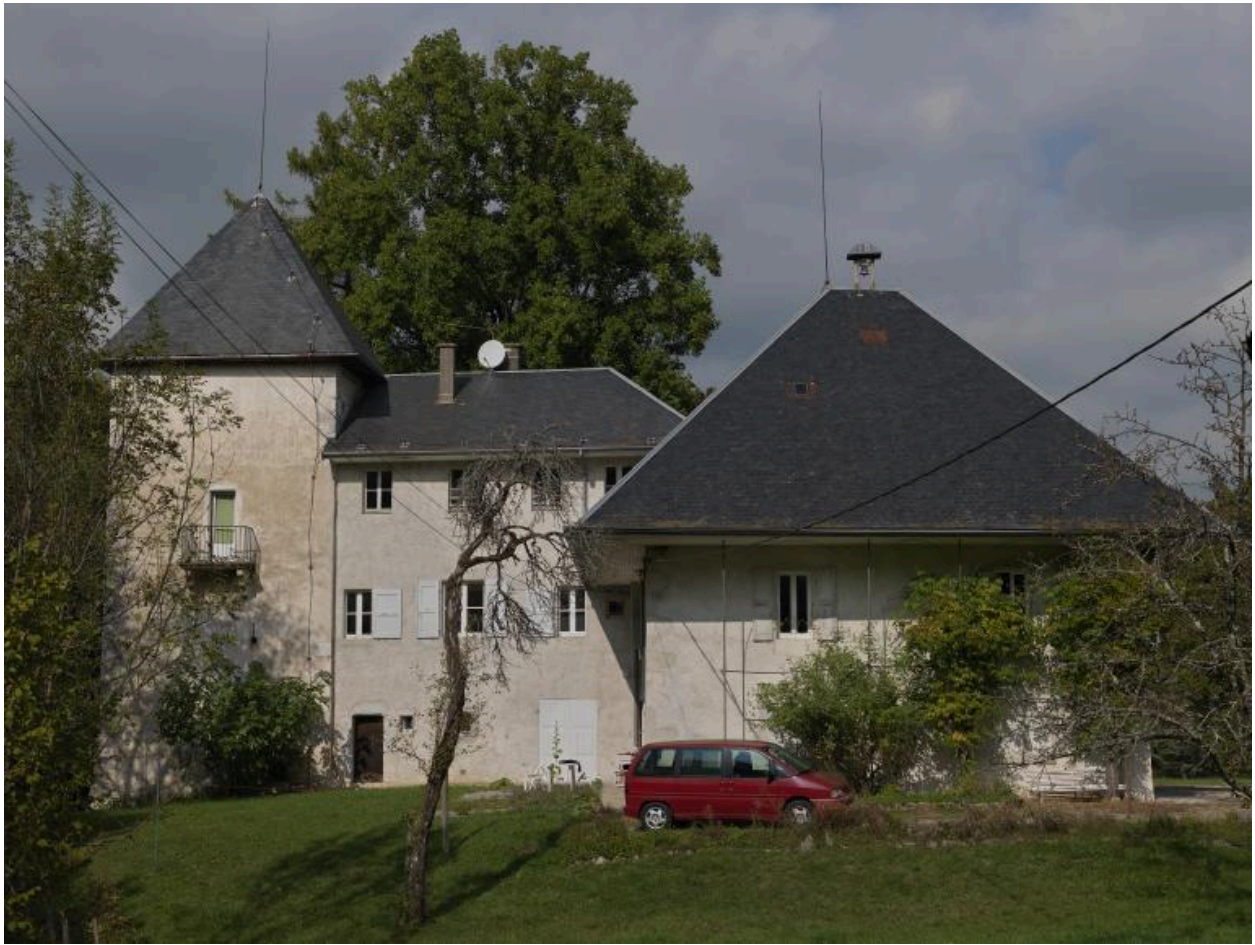
Vue d'ensemble de la façade gauche (sud) de la maison.
