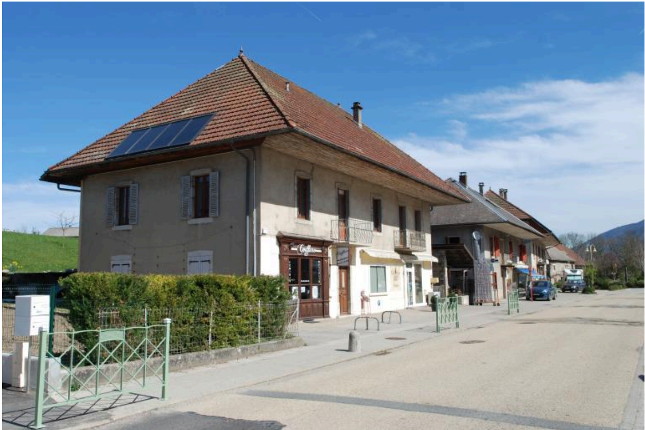
La Fay-Est, 2015 B3 1219, commerces, vue d'ensemble de trois-quarts avant gauche.
