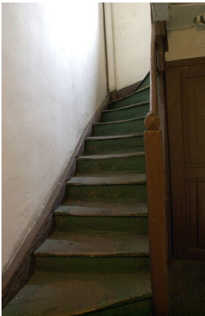
3e volée de l'escalier en bois
