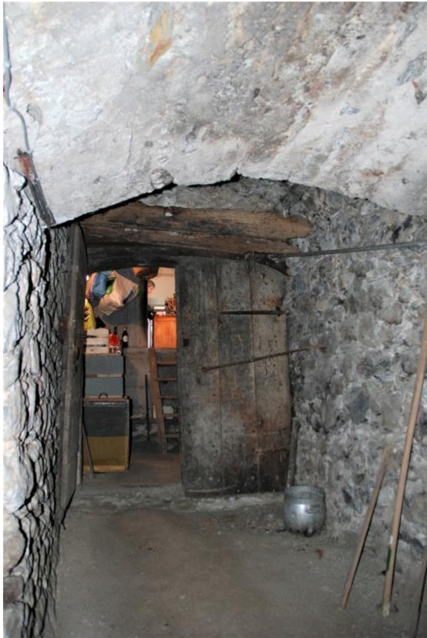
Sous-sol, porte d'accès à la cave voûtée depuis l'intérieur de la cave.
