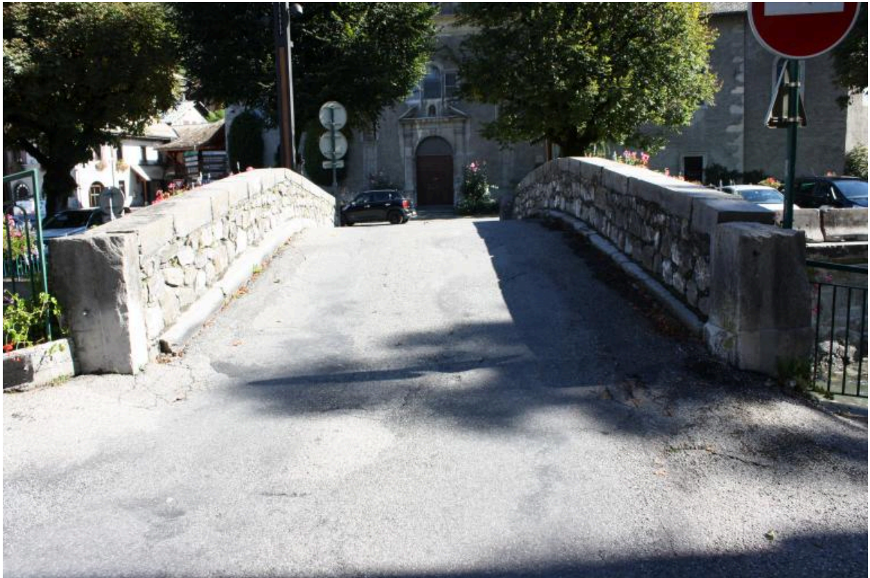
Vieux pont de Morzine, chaussée et gardes corps
