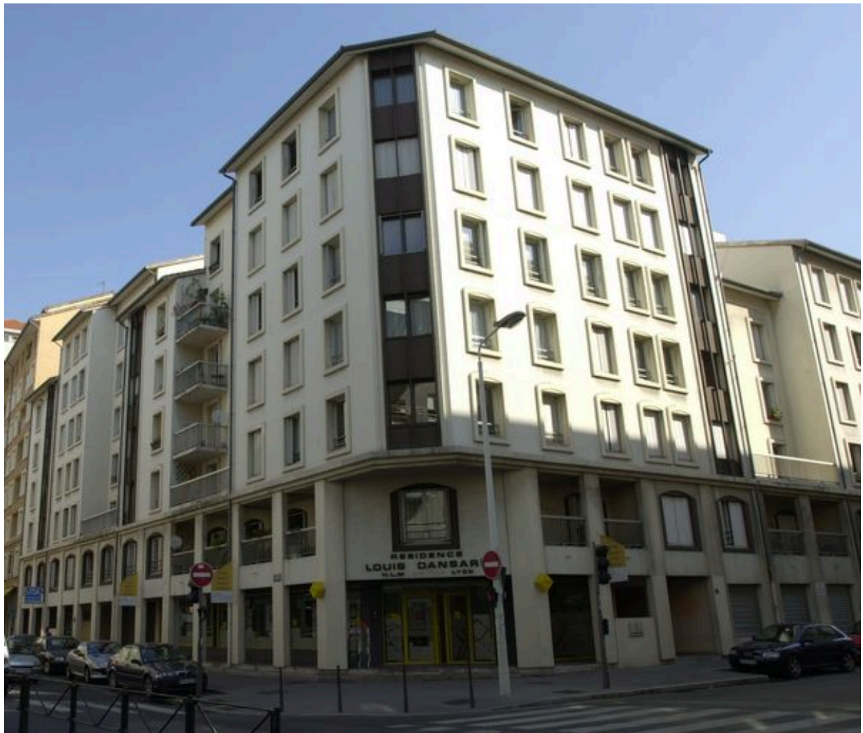
Vue d'ensemble, angle de la grande rue de la Guillotière et de la rue Louis-Dansard
