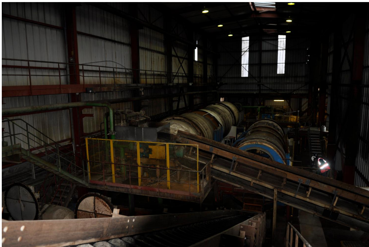
Vue de l'intérieur des ateliers
