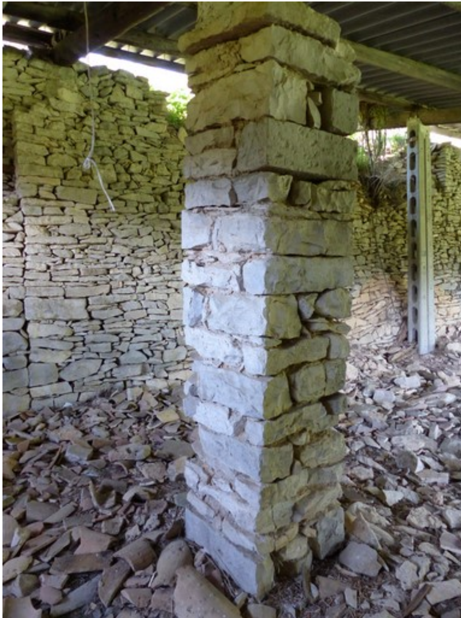
Pilier maçonné, bergerie au quartier de la Passière.
