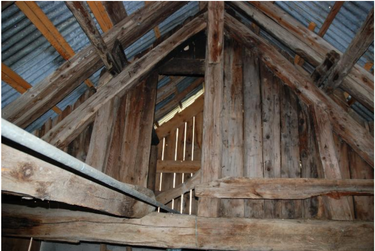
Vue de la charpente de l'étable.
