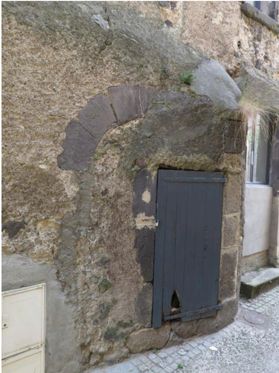
Façade latérale : ancien accès remanié
